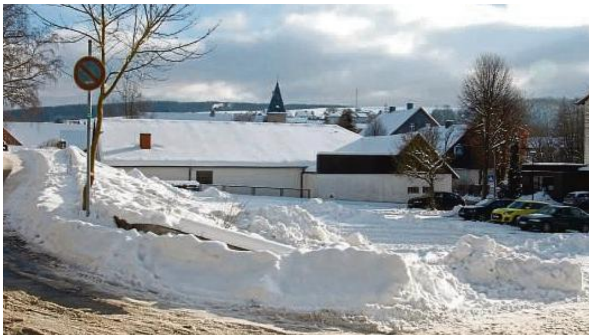
Seit Jahren eine Brache: das Gelände der einstigen Adorfer Molkerei. Die Waldecker Bank will dort und auf dem Nachbargrundstück des alten Kik-Marktes Wohnungen bauen. FOTO: SCHILLING
